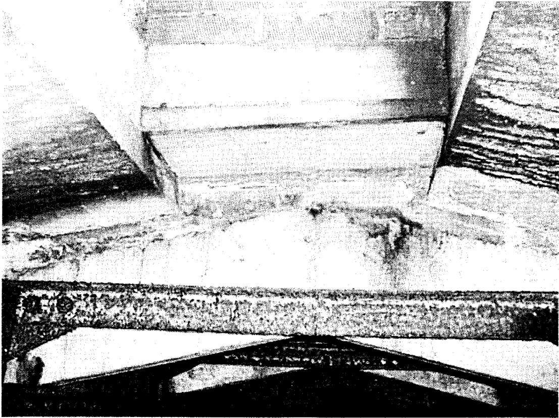
e14. Vent Access.
